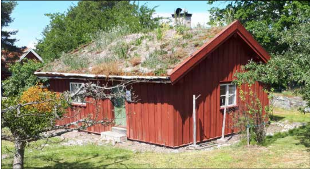
En »soldattorp« som det Anna Sofia Gustafsdotter, hendes forældre og 5 søskende boede i midt i 1800-tallet. Sådanne huse byggedes der titusinder af i Sverige i årene 1680-1901 til den stående hær. Hytterne var alle ens, bygget af brædder og med græstørv på taget. Alle målte 8 gange 5 meter med 1,9 meter loftshøjde. Soldaten, huset og familiens underhold betaltes af en »rote« bestående af 4-5 nabogårde. De fleste af disse huse er nu væk eller stærkt udvidede, men billedet oven for viser et uændret soldaterhus fra slutningen af 1700-tallet. Det stammer fra Västra Ed i det nordøstlige Småland og findes på Västerviks Museum, hvor det er fotograferet af forfatteren i juni 2019. Det har været lidt af et eventyr at flytte fra et sådant hus til et nybygget stenhus i Løkken.
